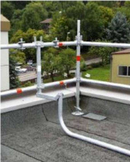
2. Die Geländerecken werden mit Gewindefußplatte, Vertikalstiel 1,0 m und Riegeln (bis maximal 3.07 m Länge) ausgeführt. Der Vertikalstiel 1,0 m dient als Eckpfosten und wird auf die Gewindefußplatte aufgesteckt. Je zwei Riegel verbinden ihn mit den angrenzenden Geländerpfosten.
