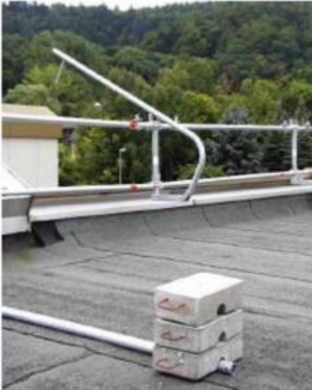
Für Arbeiten auf dem Dach darf jeweils **nur ein Ballastrohr** nach oben geschwenkt werden!
